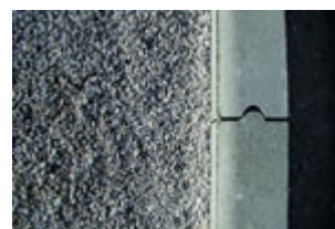
bordures en béton
