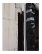
Ce processus se répète entièrement autour des chassis. Sur les joints d'angle, veiller à ne pas interrompre le géotextile.
