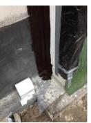
Après le recouvrement de la 2ème couche de HBS-200 sur tous les joints et chevauchements y compris le géotextile intissé, appliquer une couche de HBS-200. Après séchage, on obtient une membrane étanche, lisse, flexible et sans couture.
