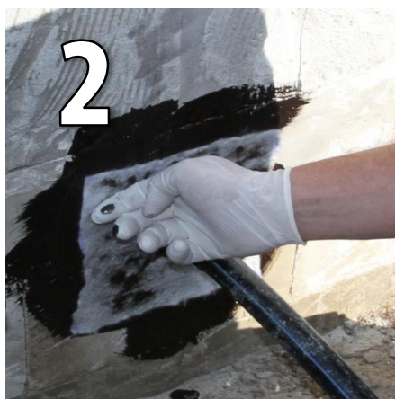
2 Poser ensuite le Geotextile sur le HBS-200
