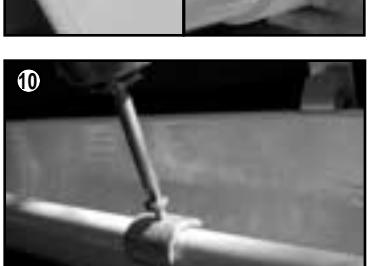
**① Montage van de haken.** Zet met behulp van een smetkoord een lijn waarlangs de haken zullen worden gepositioneerd. Bij Evaco® worden de haken voorzien op een onderlinge afstand van 60 cm. In principe mogen de haken zonder afschot of met een lichte helling (2 %) gemonteerd worden. Zorg ervoor dat alle haken perfect uitgelijnd worden. Afwijkingen zijn trouwens heel goed zichtbaar eens de goot gemonteerd is. Voorzie voor elk hoekstuk 2 bijkomende haken die het hoekstuk ondersteunen.
